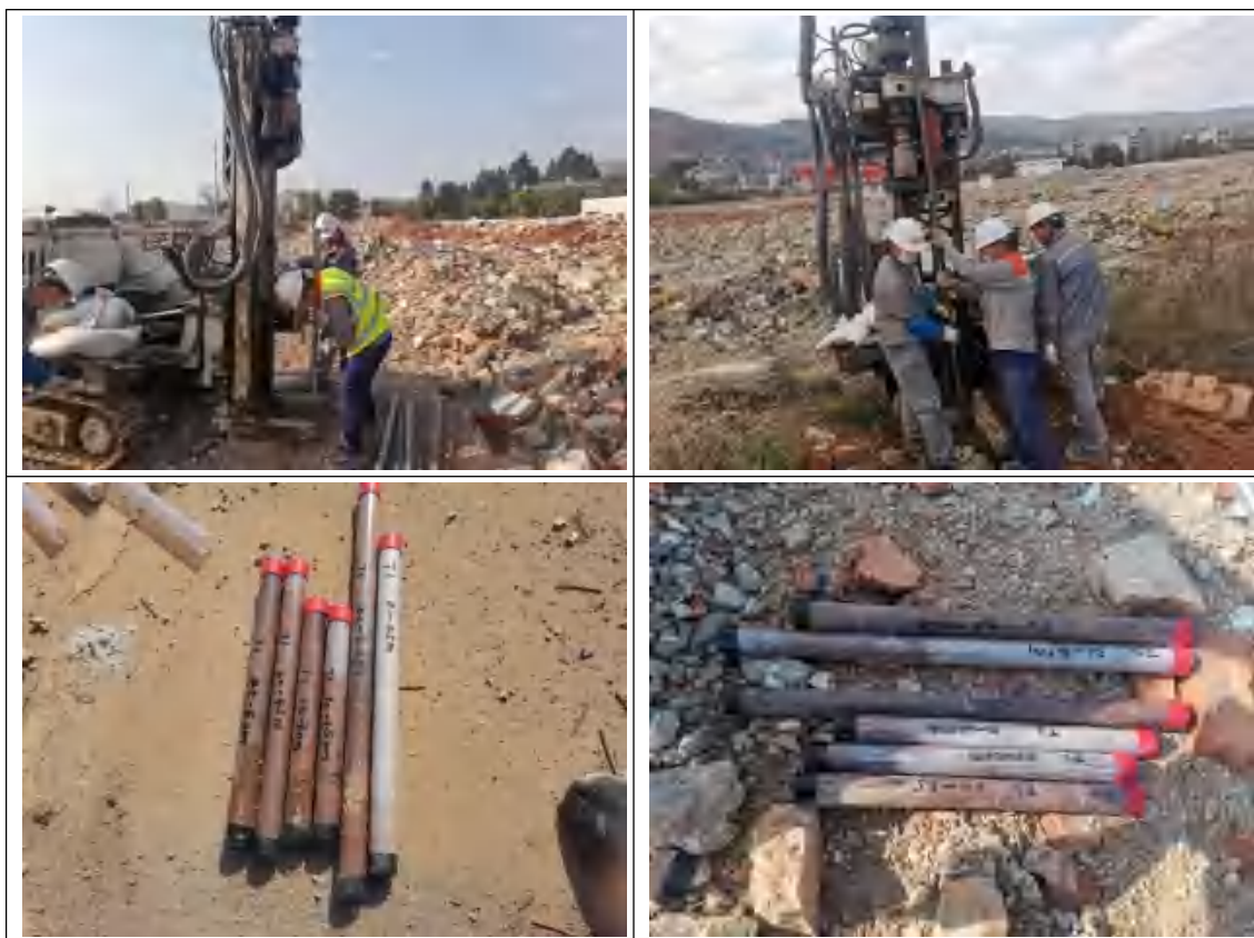
图 5.2-2a 土壤现场采样图
