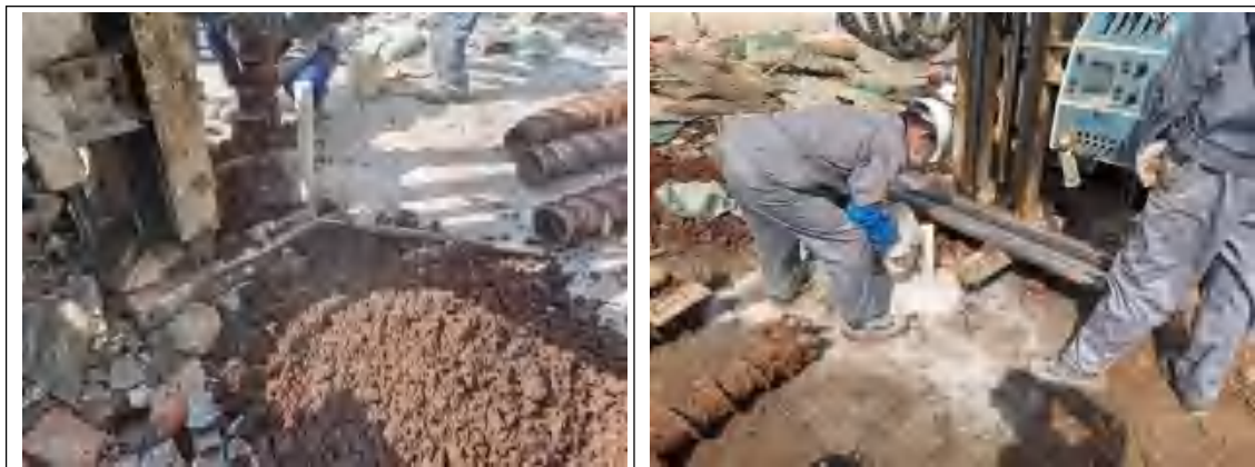
图 5.2-5 地下水建井现场图
