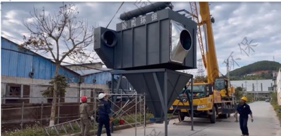
云南林老根茶业有限公司防爆型滤筒除尘器设备安装项目
