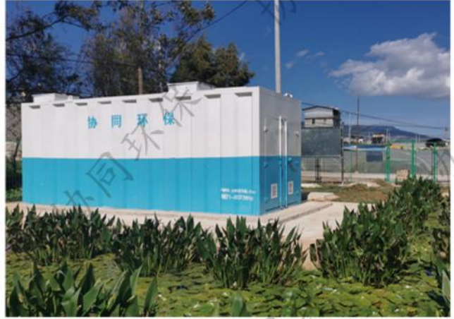
武定县狮山镇王铭厂村生活污水处理工程
